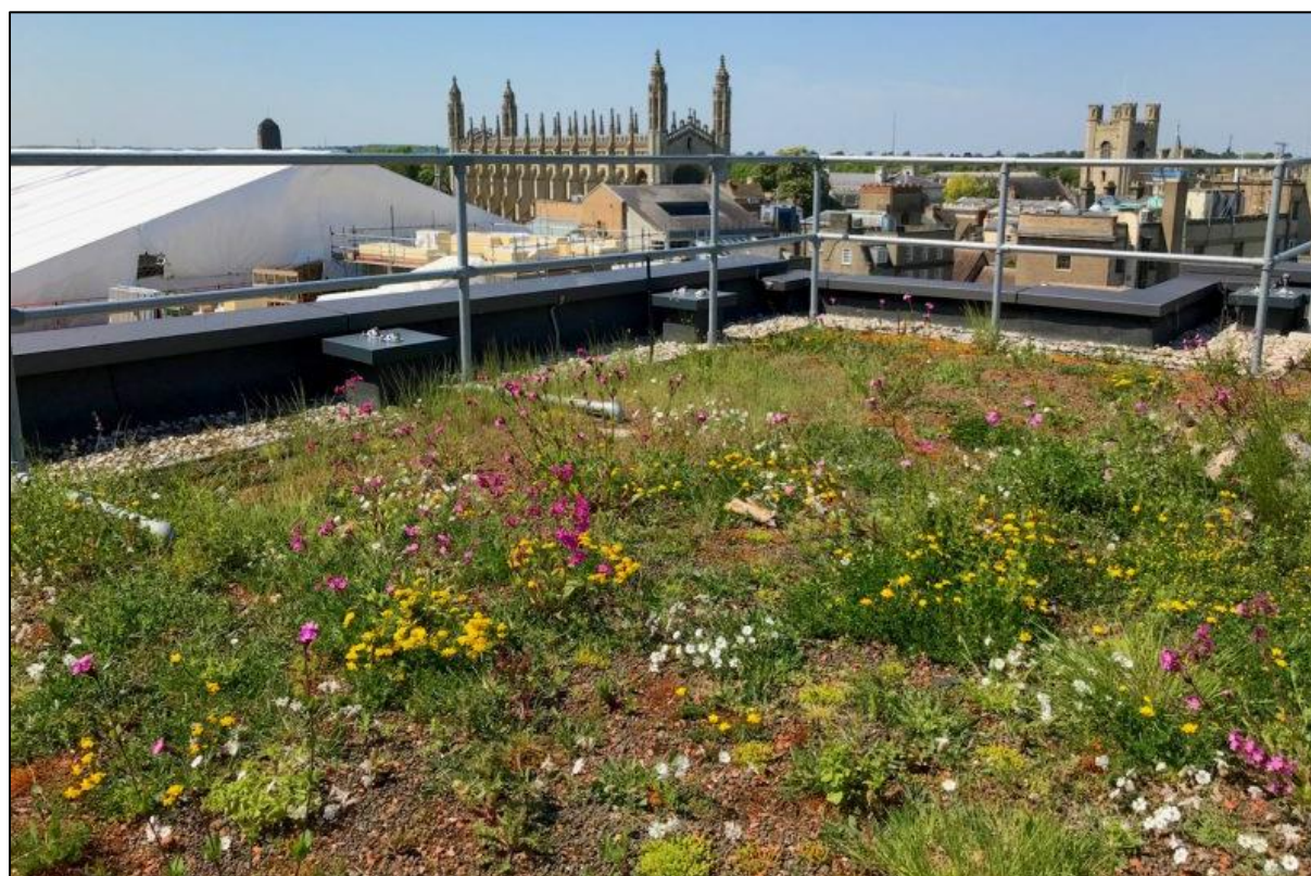
Figur 2.5. Taket på David Attenborough Building i Cambridge. Bildet er hentet fra https://livingroofs.org/
